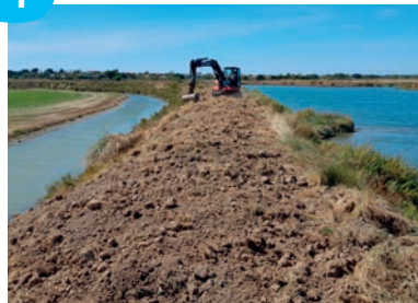
Digue de la Vie - La Bodelinière Le Fenouiller
