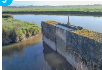
Démantèlement de deux ouvrages (avant/après) Le Fenouiller
