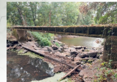
Seuil de la Flomière (avant/après) Maché / La Chapelle-Palluau
